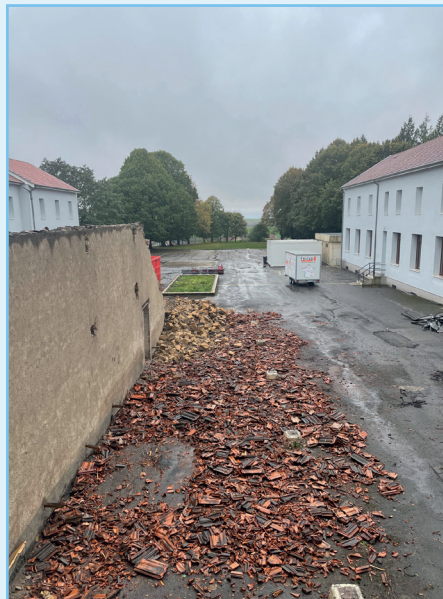
Démolition du préau
